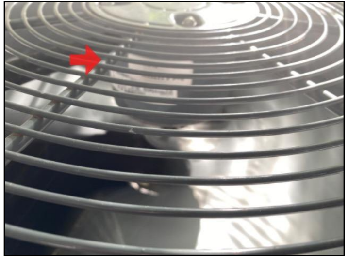
120. No Rust on Fan Motor
