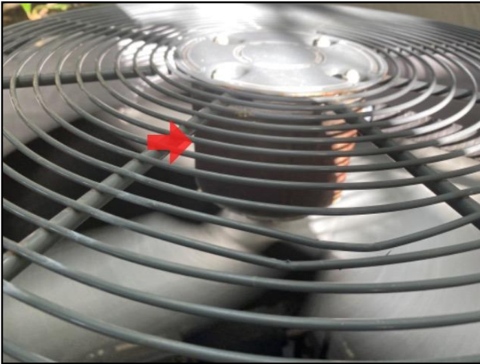
119. Rust on Fan Motor
